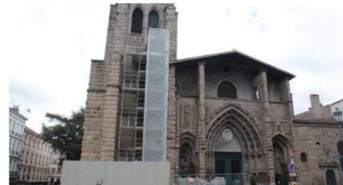
La tour du clocher est entourée d'échafaudages. Photo J. Gardon
